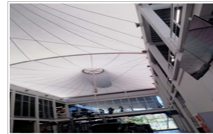
F5: Interior de aula
