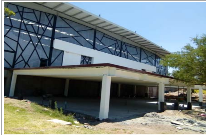
F1: Fachada principal
