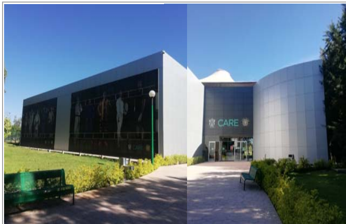
F1: Fachada principal
