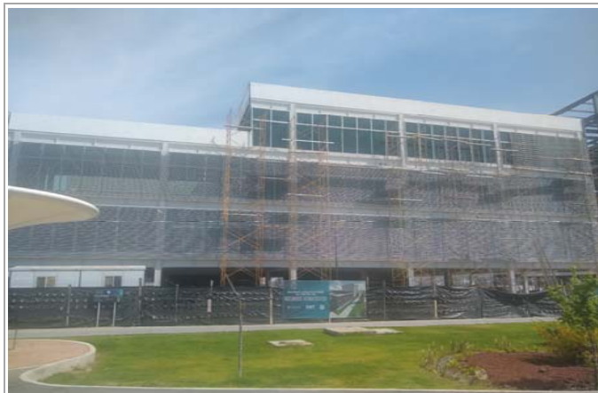
F1: Fachada principal
