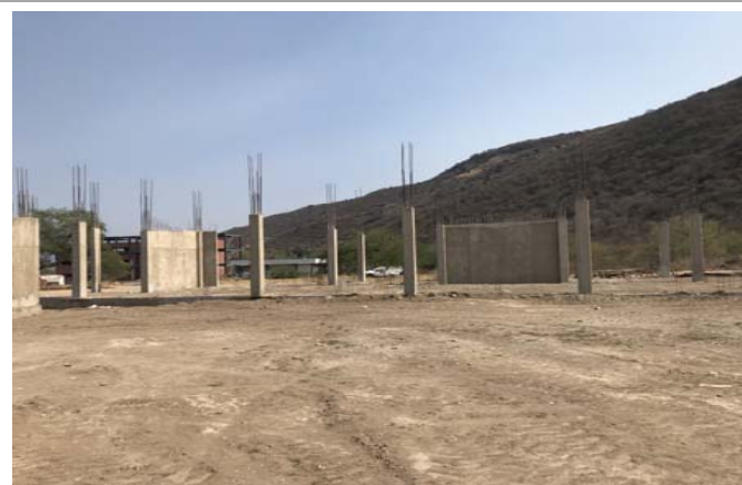
F1: Fachada principal
