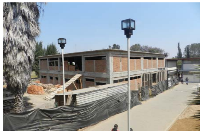
F1: Fachada principal
