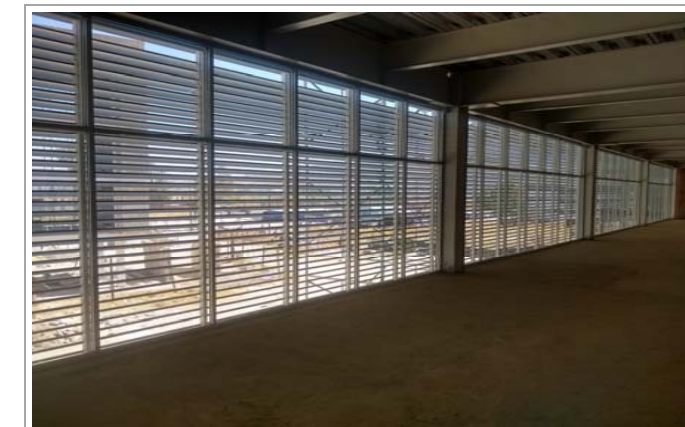
F5: Interior de aula
